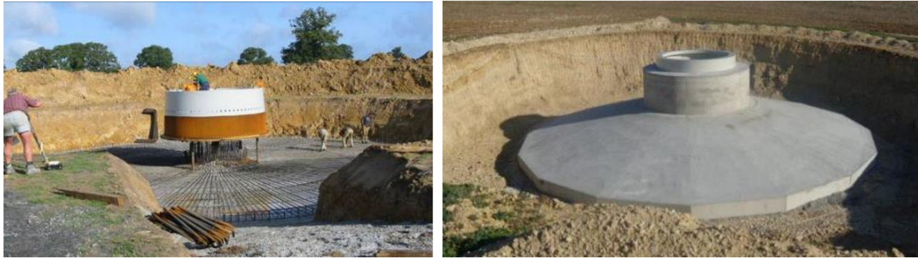
Figure 16 : Le ferrailage et le coulage d'une fondation d'éolienne
