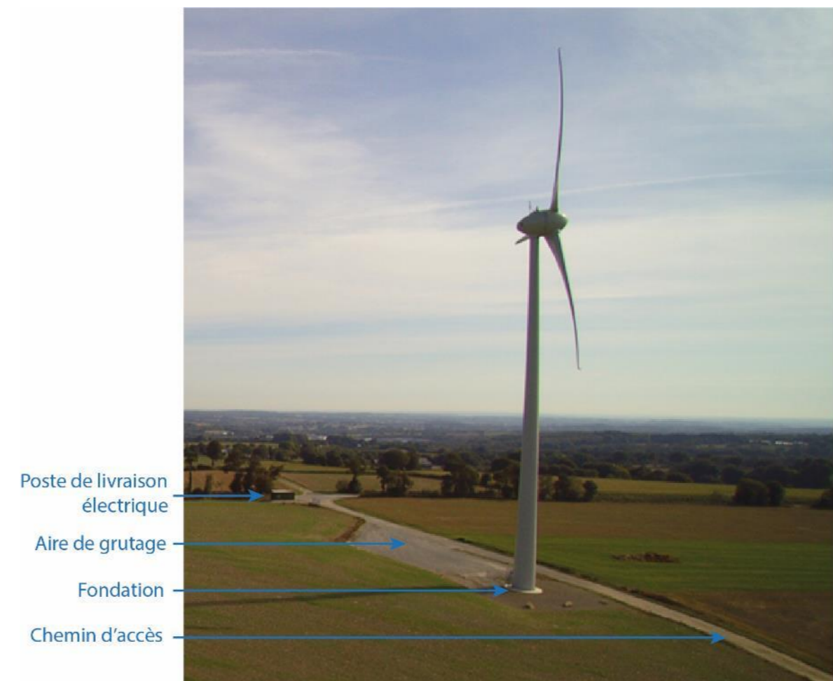
Figure 3 : Une éolienne et ses aménagements annexes (Source : AEPE Gingko)
