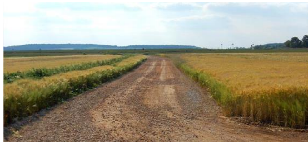
Figure 17 : Exemple de voie d'accès à un parc éolien
